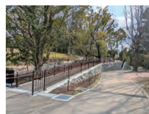
憩の森東側のスロープ整備
